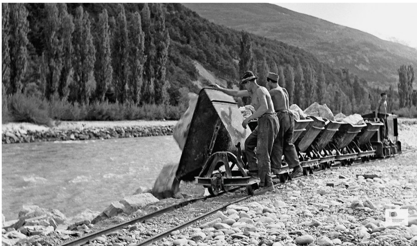
Ces travaux d'empierrement ont été réalisés en 1946. Ils font partie de la 2 e correction du fleuve, effectuée entre 1930 et 1960.
